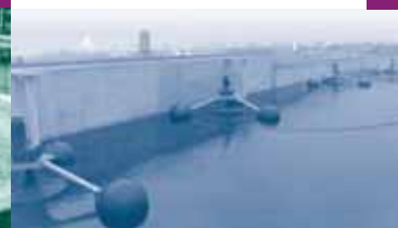
Turbine di aerazione - serie ADS installazione galleggiante Aeration Turbines - ADS series Floating Installation
