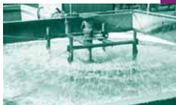
Turbine di aerazione - serie ADS installazione fissa Aeration Turbines - ADS series Stationary Installation
